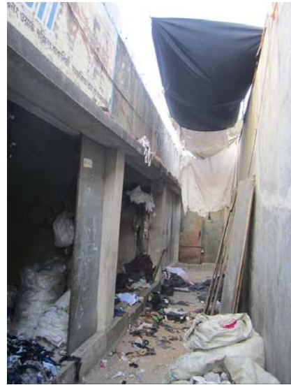
写真-4 Bou-bazar 密集市街地 における火災現地調査 (路地左側が延焼箇所、奥は行き止まり)
