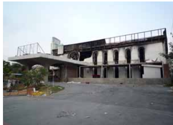
東面外観（北東側から撮影）
