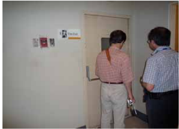
避難階段入口 (防火戸の一部は網入りガラス)
