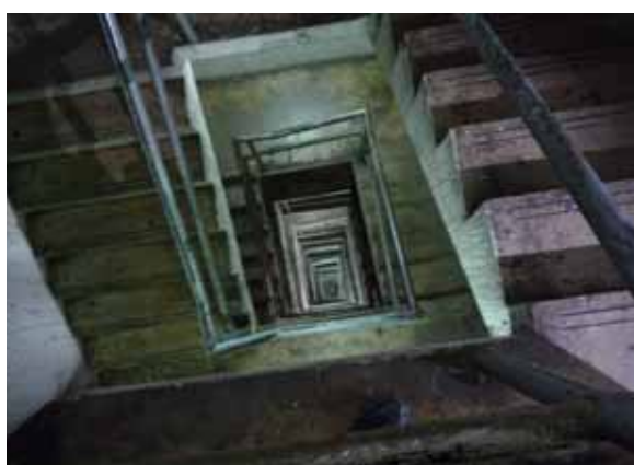
階段室内（中央が吹き抜けている）
