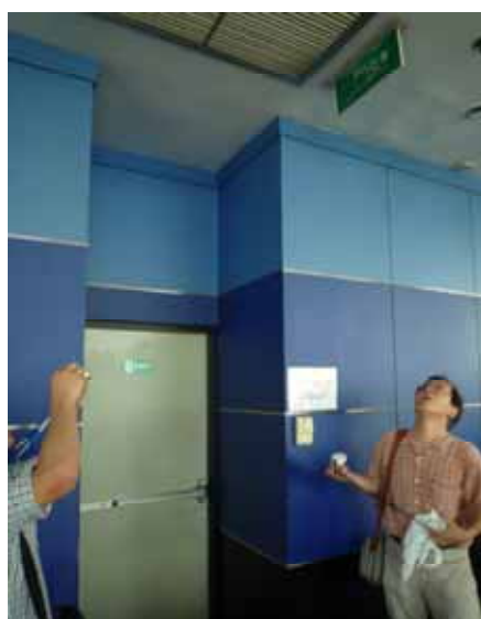
天井面に誘導灯（？誘導表示？）
