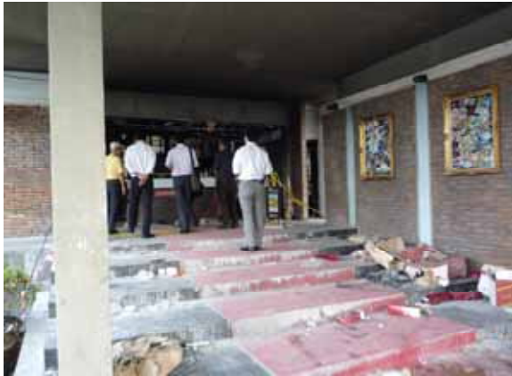
正面入口（正面カウンター左が入口）
