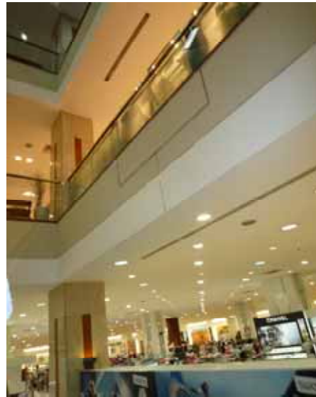
吹抜近傍の天井面 ( SS など無し )
