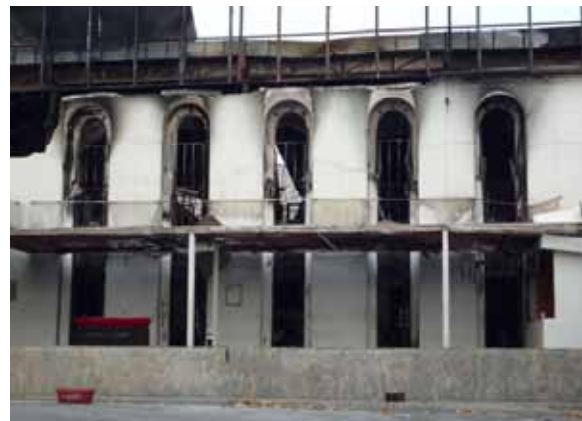
エントランス右の東面外観（庇の下は喫煙所）
