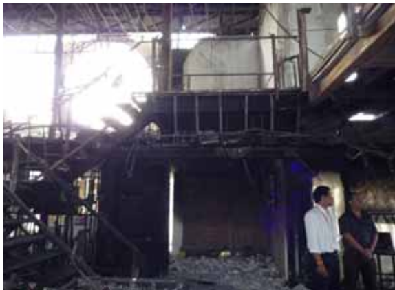
東面正面入口（左は階段、右は出入口）
