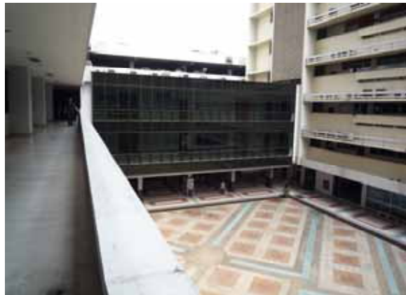
中庭（右が左記の建物の裏側、左にも建物有り） 右の建物が約10階層、左の建物が約20階層 建築指導部は左側の建物の3階ある
