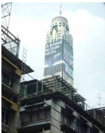
南東側からの外観
