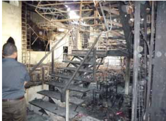
入口すぐ右の階段（1Fフロアは下がっている）
