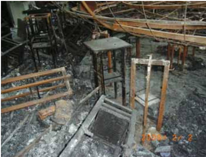
図3 客席フロアの固定スタンド 右上は落下したシャンデリアの一部
