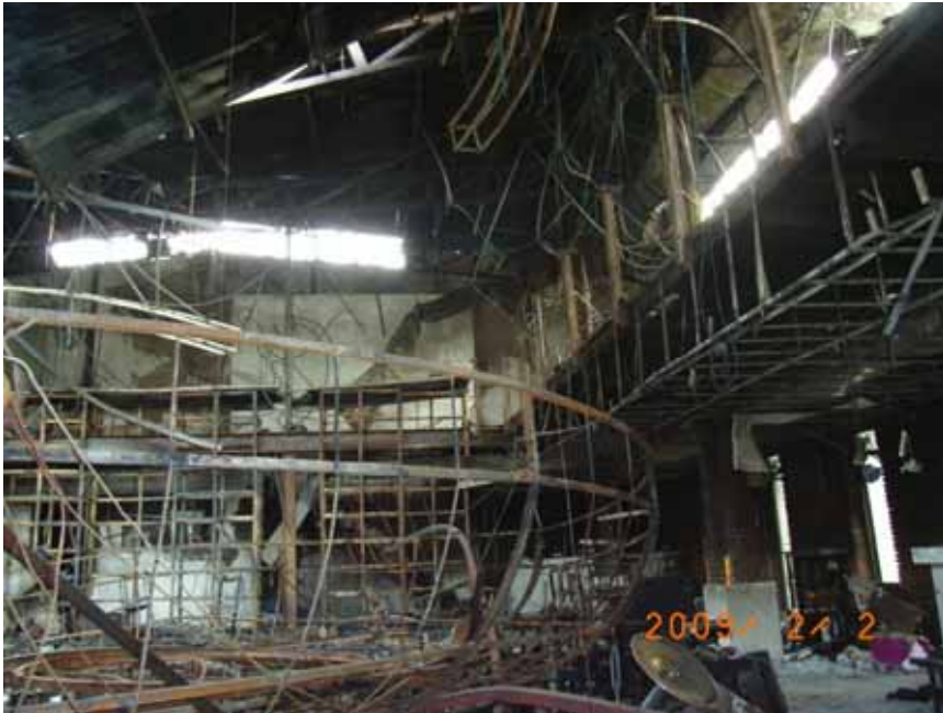
図4 客席フロアに落下したシャンデリア（左下半分に見える円形の構造物）
