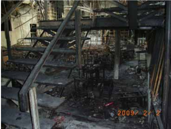
図12 左側は中2階からエントランスホールへ降りる階段。右側は客席フロアに降りる階段。
