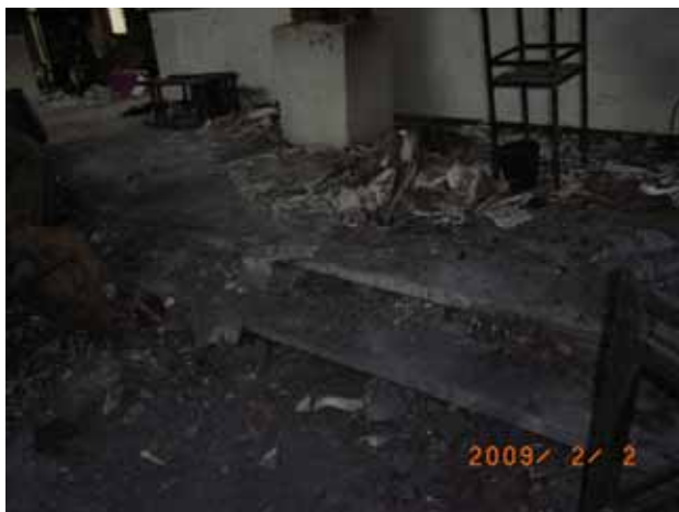
図7 客席フロアと東側テラスの間の段差
