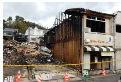
写真 1 界壁延焼の様子城崎温泉市街地火災(2015)
