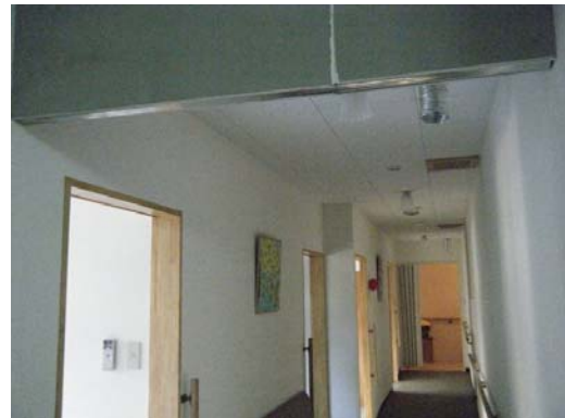
共用部横の通路（手前上部は取り付け中の防火戸）
