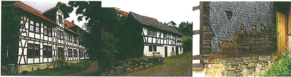
図 10 焼け残った小学校（現役） 図 11 焼け残った住居 図 12 同、下見板にスレート貼り壁面
