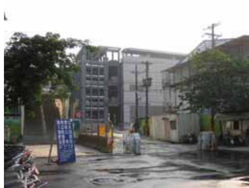
図 18 商業施設（耐火被覆施工現場）
