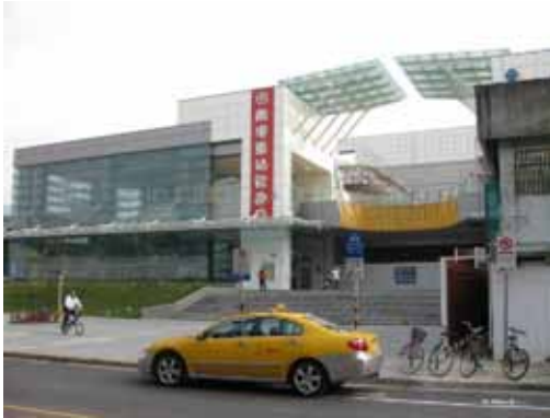
図 17 高鉄港南駅外観
