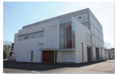
火災科学研究センター実験棟 建築面積：約 1500 平方メートル 延べ面積：約 1900 平方メートル 高さ：約 20 メートル
