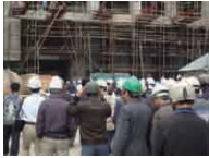
高層ビル建設現場における見学実習
