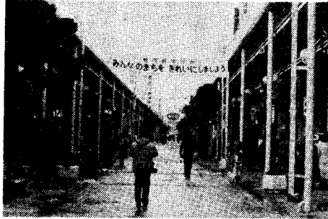
写真2 仙台市一番町アーケード。車道をモール化しベンチや植栽が設置された。
