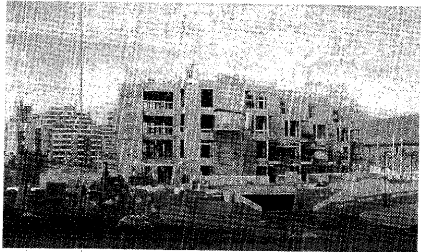
写真2 建設中の木造3階建（4階建？）共同住宅
