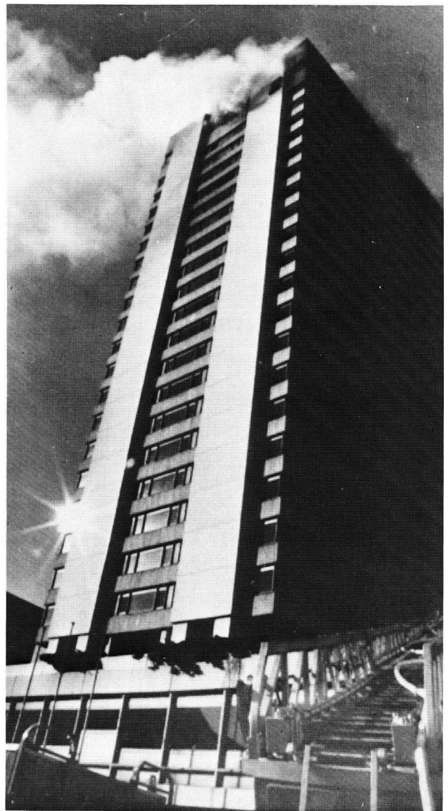
1988年2月14日、スイス・チューリッヒのホテル・インターナショナルの火災。28階建の27階より出火、6名が死亡した。
