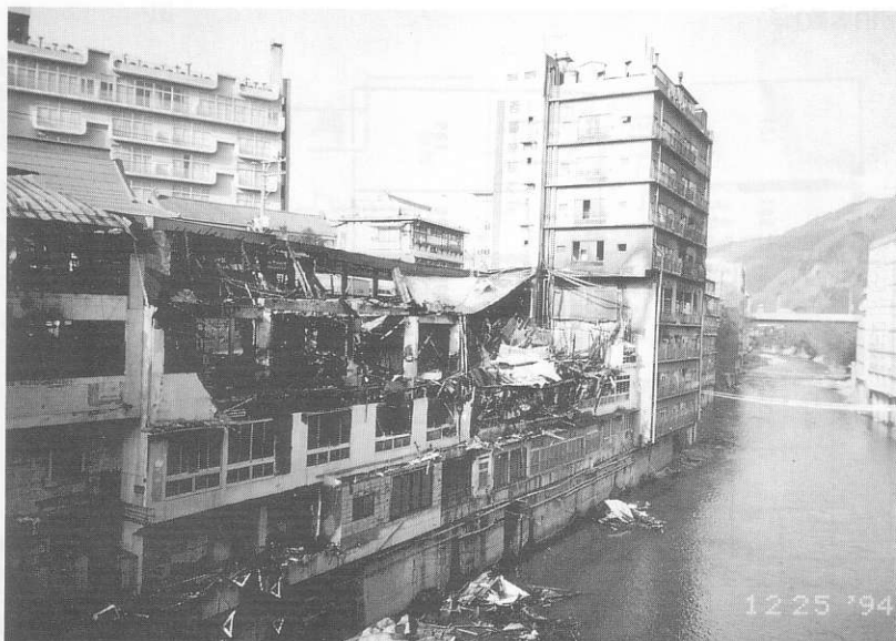
本館東側の焼失状況（摺上川側）
