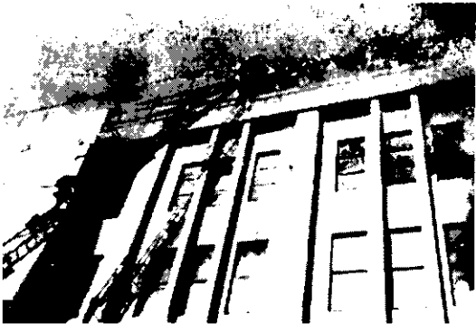
熊本市大洋デパート火災（昭和48年）
