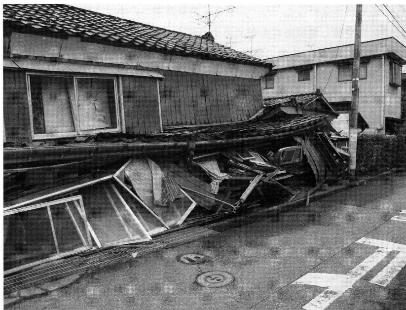
新潟県中越沖地震被災地の状況
