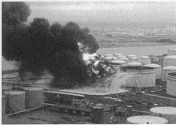
石油タンク火災の消火活動
