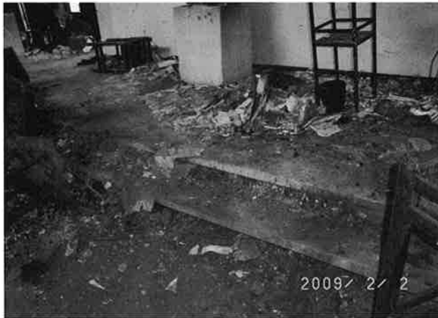
写真7 客席フロアと東側テラスの間の段差
