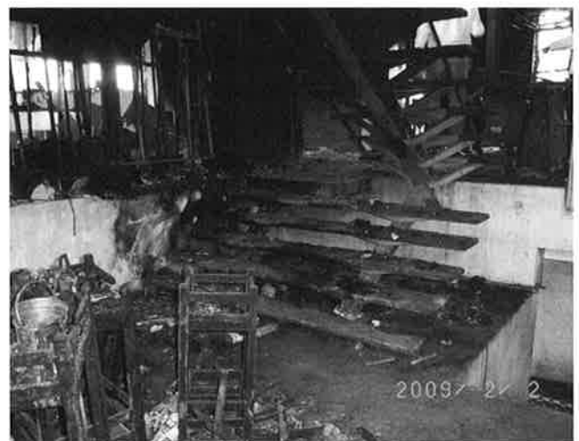
写真9 客席フロアからエントランスホールへ上がる階段。階段の右半分は、2階へ上がる階段の下部に邪魔されて使えない。右は地下トイレへ降りる階段。
