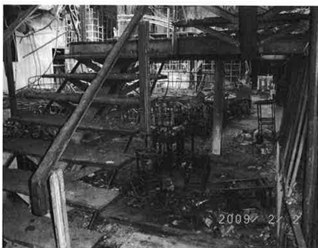
写真12 左側は中2階からエントランスホールへ降りる階段。右側は客席フロアに降りる階段。
