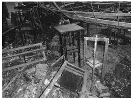
写真3 客席フロアの固定スタンド 右上は落下したシャンデリアの一部
