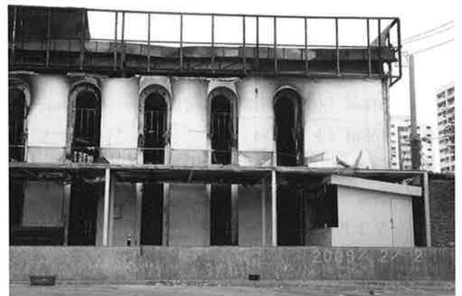
写真6 東側外観と窓の様子
