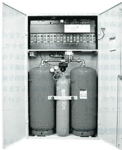
ルートBにより防火安全性能が確認された消防用設備(パッケージ型自動消火設備)
