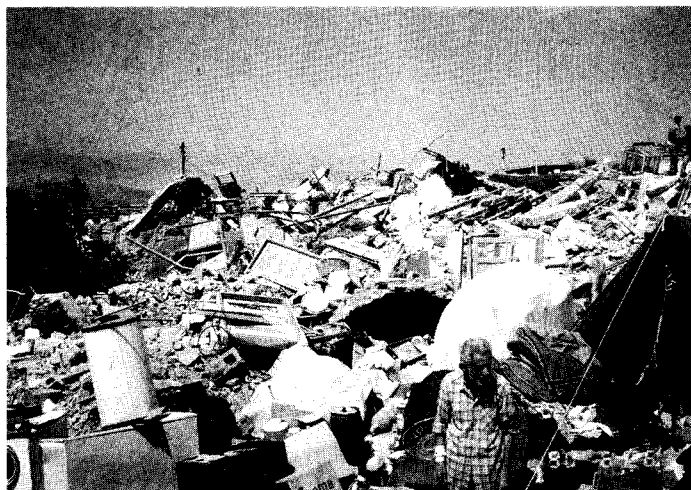
イラン北西部ギラン州の被災状況
