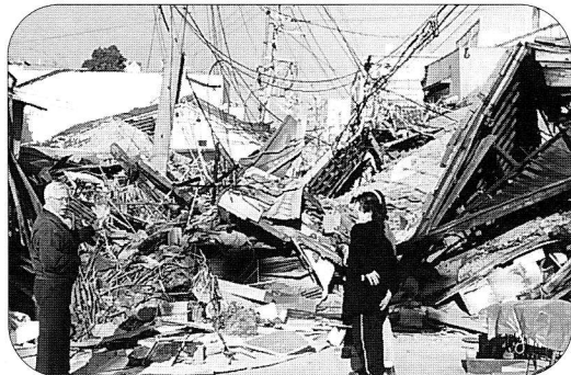
阪神・淡路大震災で壊れた住宅
