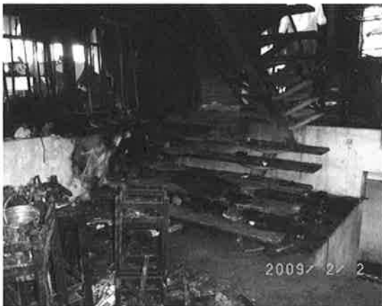
写真2 客席ホールからエントランスホールへの階段(図1(E))
