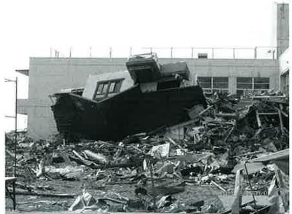
写真2 建物の周囲に堆積した可燃物（仙台市宮城野区）
