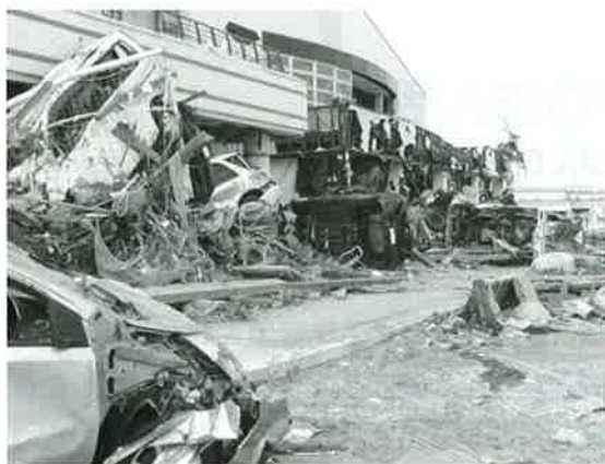
写真4 津波で中野小学校前に堆積した車
