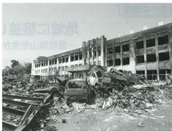
写真6 石巻市門脇小学校（撮影：東大山田研究室）
