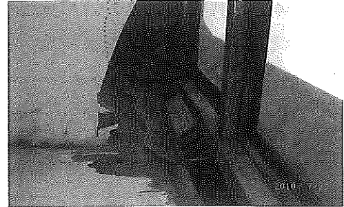
写真3 高層複合ビル火災で下階に延焼したルート(バングラデシュ)
