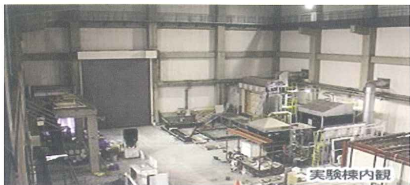
写真4 東京理科大学の実験棟内部
