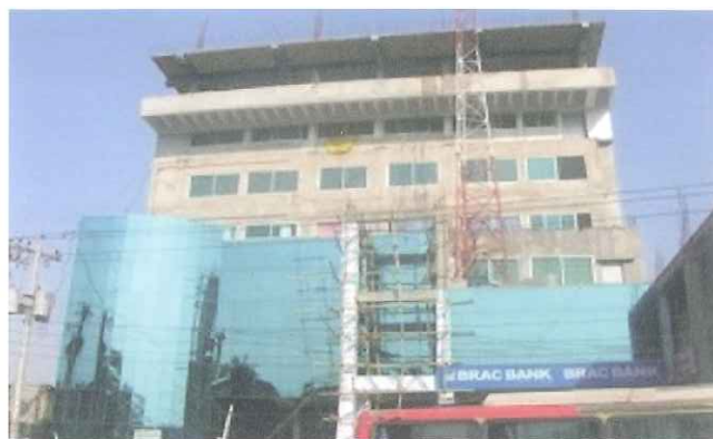
写真5 倒壊前のラナプラザビル（提供：FSCD）
