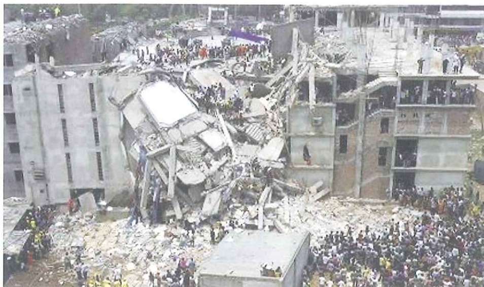
写真1 ラナプラザビル倒壊事故（バングラデシュ：webpage から）
