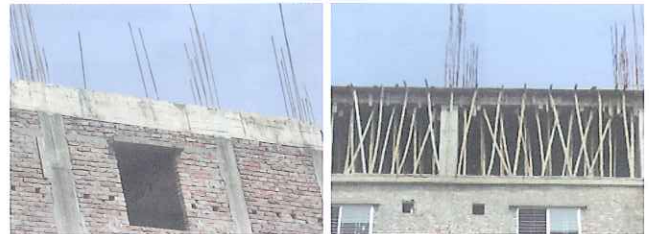
写真10 倒壊現場と隣接する工事中の建物の写真(柱の配筋状況がわかる。)
