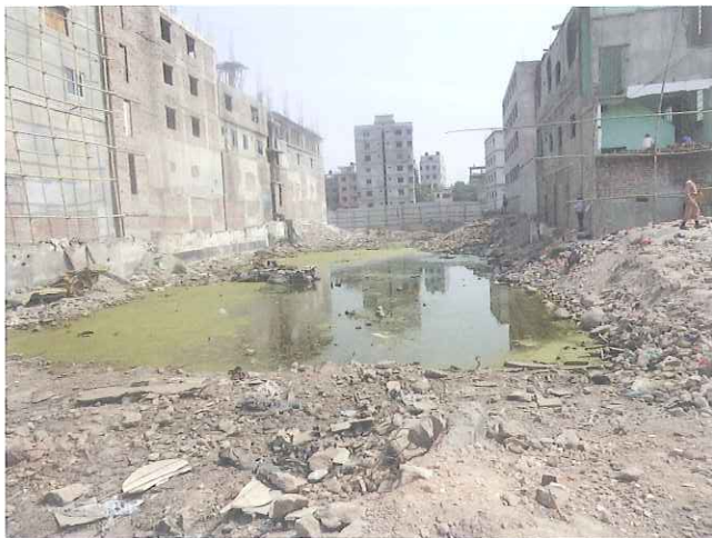
写真8 倒壊現場の跡地の状況
