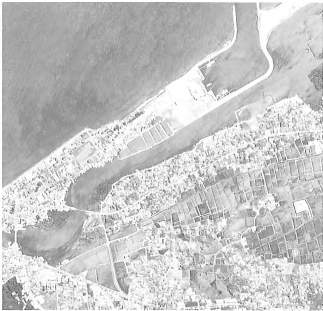
・2004年（平成16年）津波発生前
