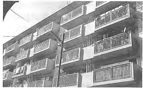
写真1 二戸ずつ連続したバルコニー
