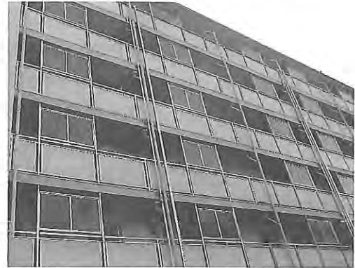
写真2 外気に開放された廊下と防風スクリーン
