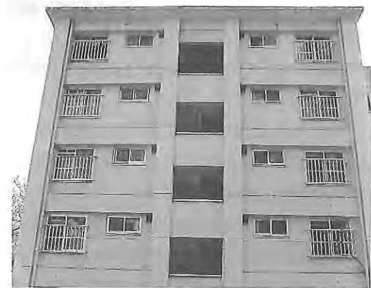
写真3 外気に開放された階段室
