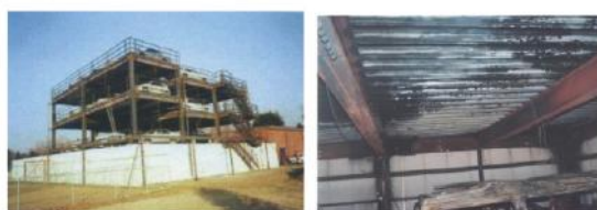
a) 外観 b) 車両上部の損傷
