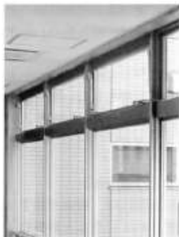
写真2 自然排煙の排煙口の例
