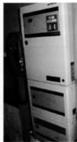
写真3 火災通報装置と確認用の電話
