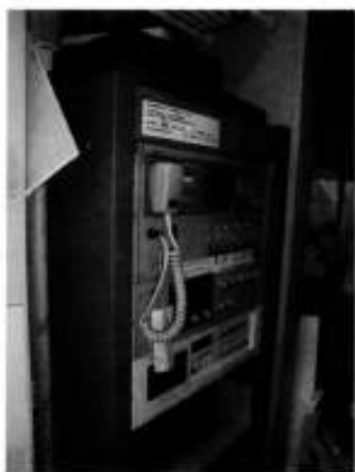
写真5 館内放送設備の例
