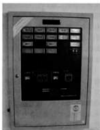
写真4 自動火災報知設備受信機の例
