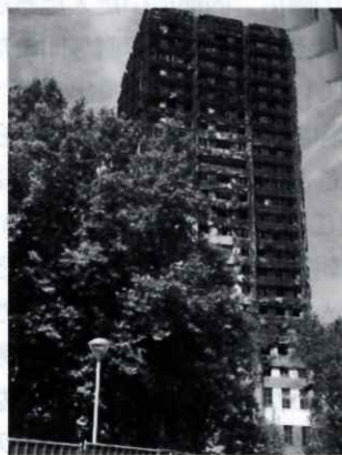
写真 鎮火後のグレンフェル・タワー
