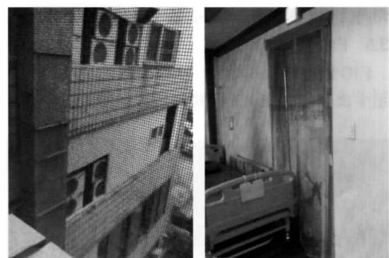
写真7 バルコニーの状況(左: 狹いバルコニーに空調機の室外機設置状況, 右: 室内側バルコニーへの扉: 布製の飾りで解り難い。)
