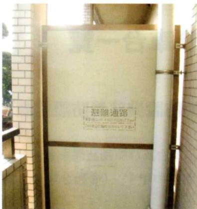
図3-5 容易に破壊できる仕切り板
