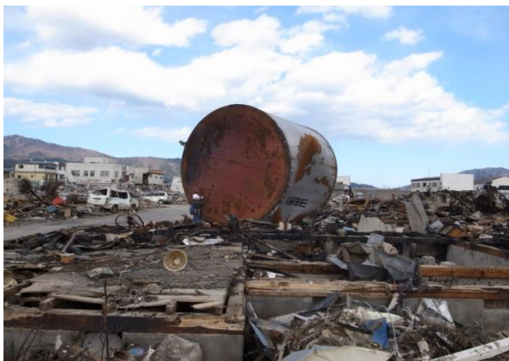
図5 津波跡地に取り残された燃料油タンク（岩手県山田町陸中山田駅周辺）
