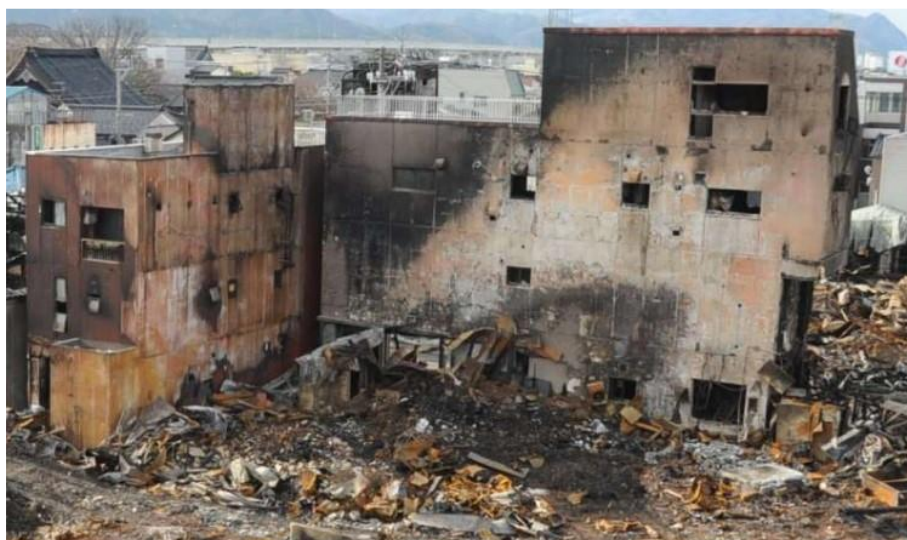
図3 市街地火災で延焼した耐火建築物（2016年12月糸魚川大規模火災） （撮影 総務省消防庁消防研究センター）
