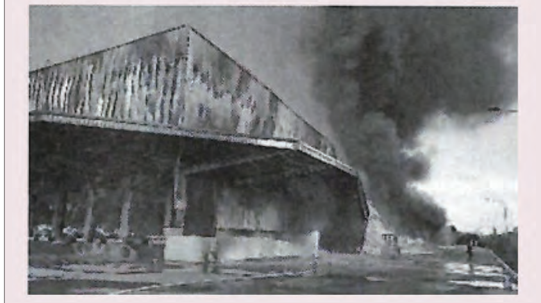
図5 美福倉庫火災(上)とカルフルール倉庫火災(下)
