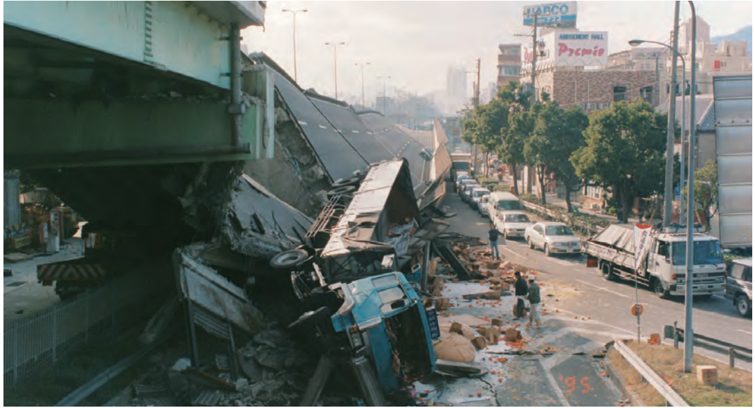
阪神・淡路大震災で倒壊した阪神高速道路(国道43号岩屋交差点付近)
