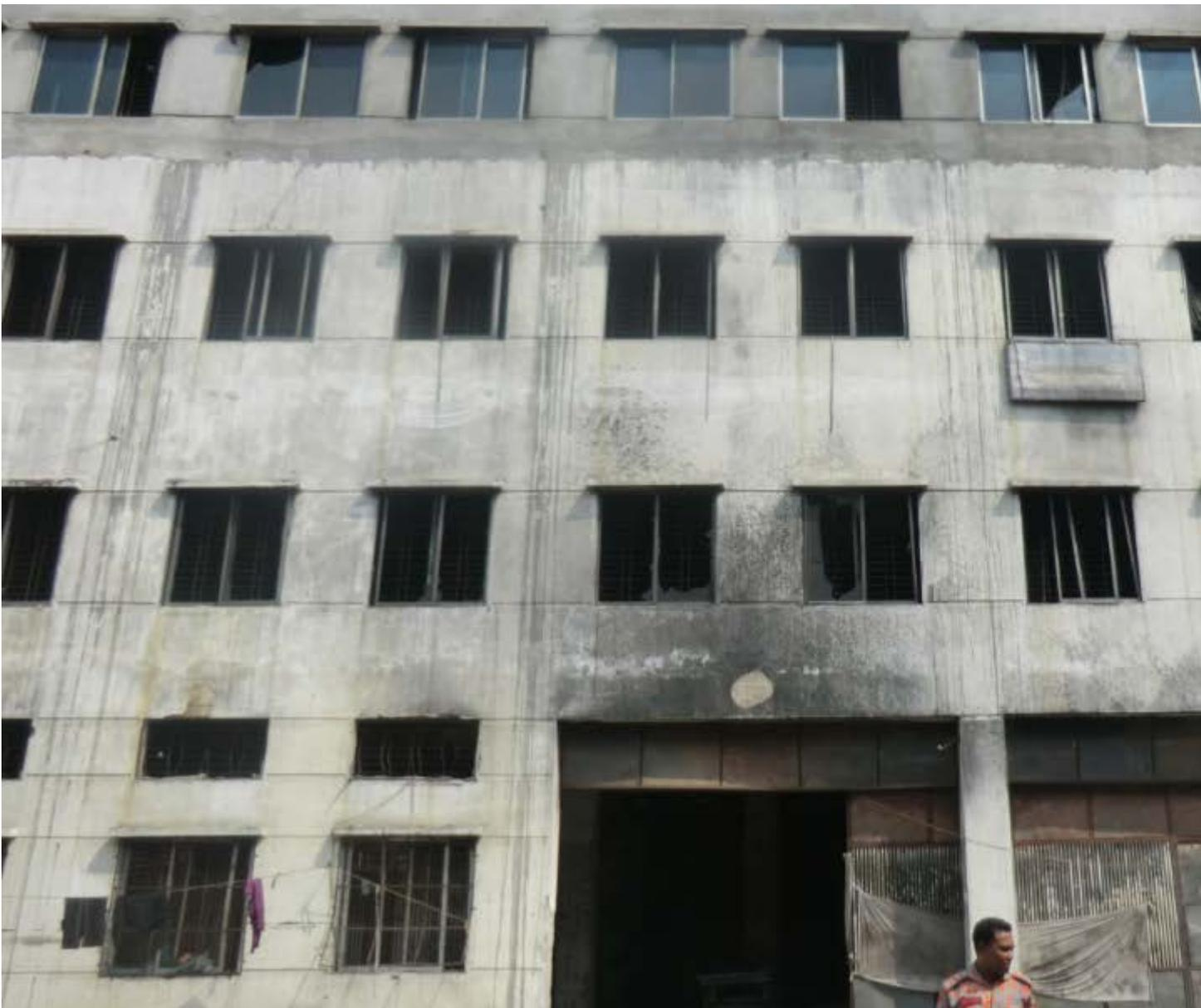
写真2 延焼状況1（1階の倉庫で衣類が激しく延焼している。）(FSCD 提供)
