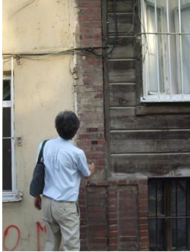
レンガで造られている防火壁
