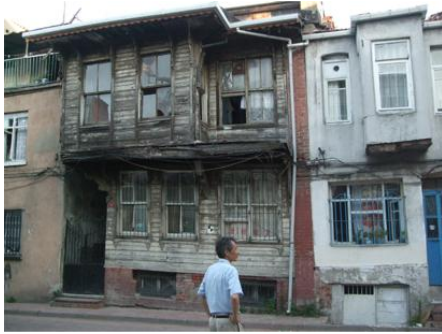
防火壁を介して連坦している建物
