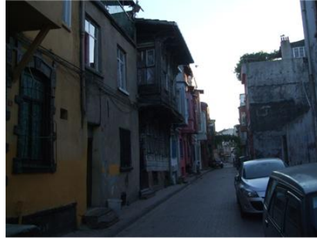
道路幅員 5m の街路に面して建つ木造建築
