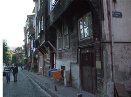
老朽化した木造建物群
