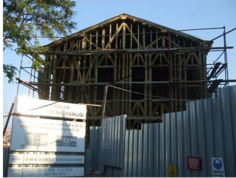
建設中の木造建物
