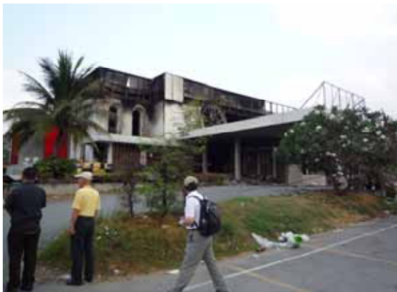
東面外観（南東側から撮影）
