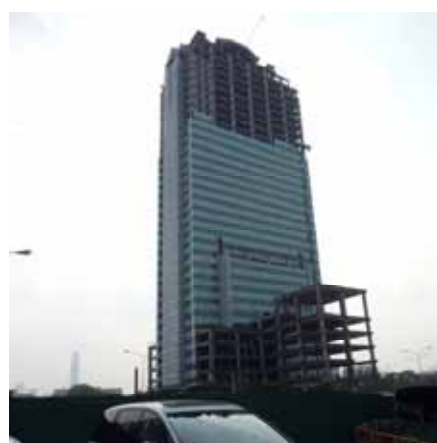
隣接敷地に建設中のバンコク都庁舎（？）
