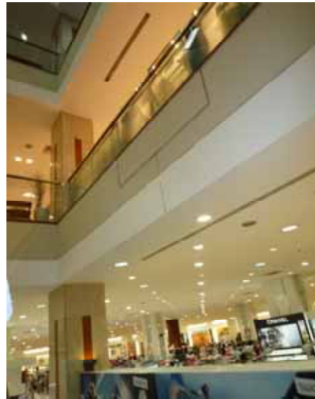
吹抜近傍の天井面 ( SS など無し )
