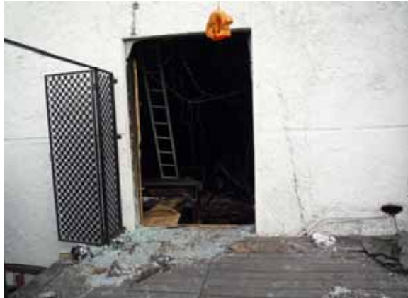
南面左のVIPルームの窓（救助のため破壊） 窓下端高さはVIPルーム床面から約1.5m
