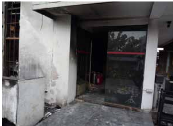
南東角の出入口の外観（左が南面）
