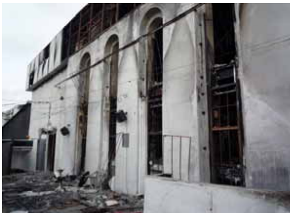
南面外観（南東側から撮影）
