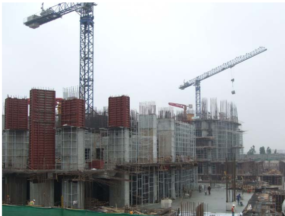
工事中のハノイ・ランドマークタワー
