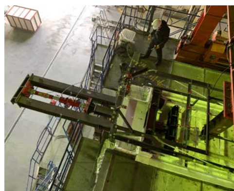
写真1 2018年度の実験の様子 (多目的載荷装置の加力フレーム上部から見下げ撮影)
