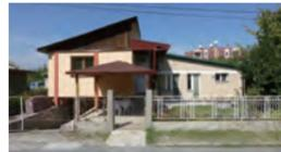
写真2 建物を桁行き方向に半分に切断し、梁間を玄関の幅だけ広げ、正面向って左手に地下車庫を新設し、車庫部分に鉄骨を建てて床を設け、その上にもともとの屋根を載せている。外壁にはタイルを貼っている。
